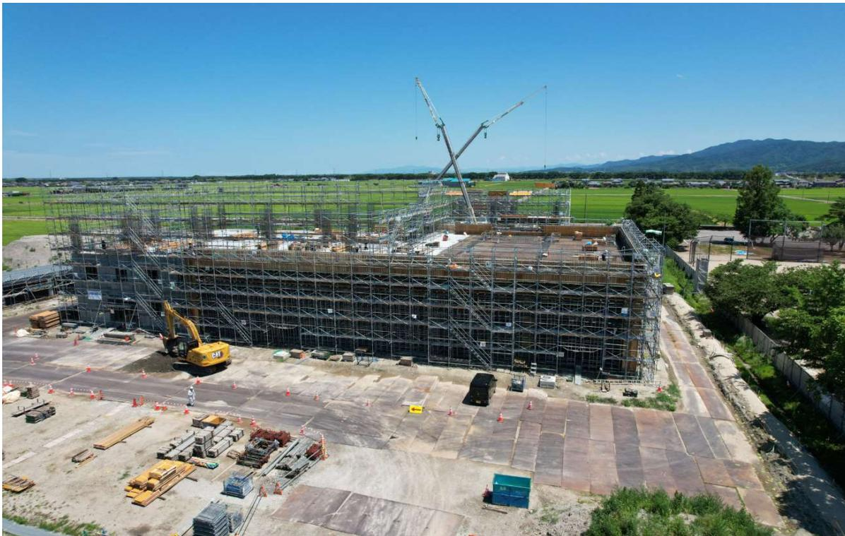
現場状況（庁舎棟 PC工事） ※PC：プレストレストコンクリート
