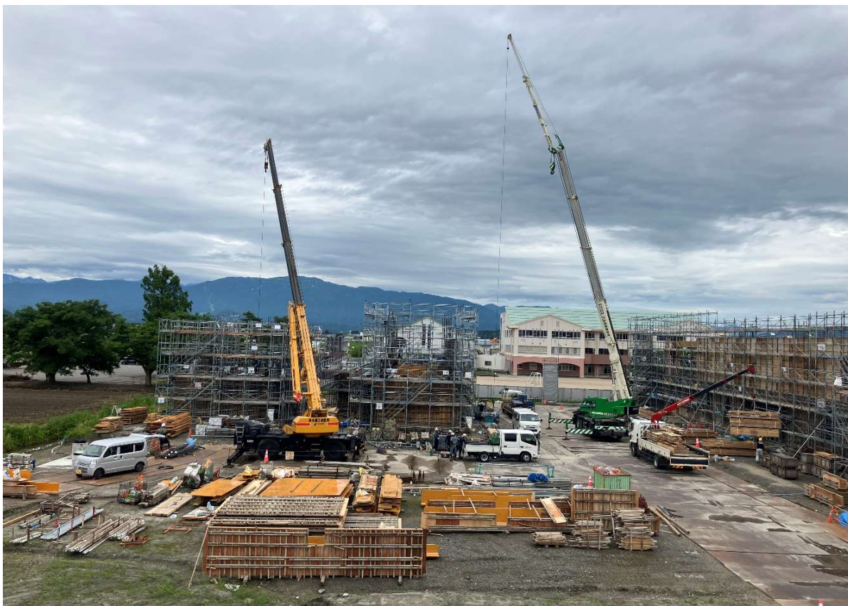
現場状況（庁舎棟、訓練棟 躯体工事）
