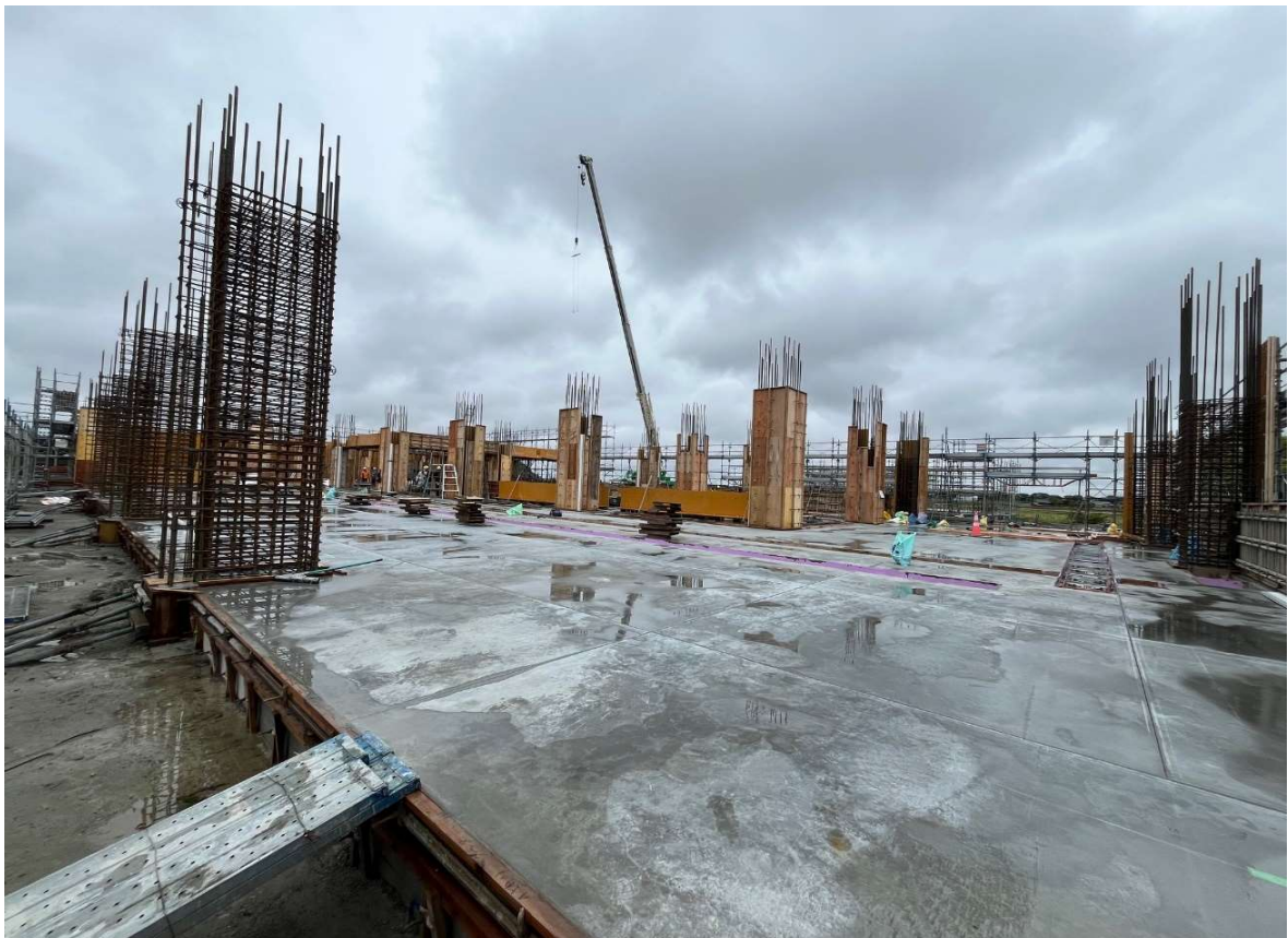
現場状況（鉄筋、型枠工事）
